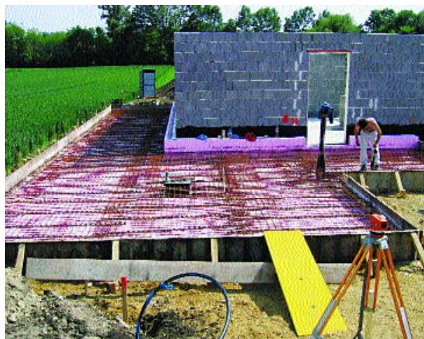
Fot. 2. Polistyren ekstrudowany najlepszy materiał izolacyjny w miejscach wymagających dużej nośności i odporności przeciwwilgociowej.
