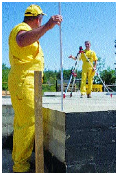
Fot. 10. Wykonanie nośnych warstw podłogi na gruncie przed wznoszeniem ścian wewnętrznych to obecnie ważny element bezpieczeństwa i wygody na placu budowy.
