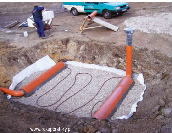
Fot. 4. Żwirowy GWC z widoczną czerpnią powietrza układem rozszacującym i przyłączem do budynku.
