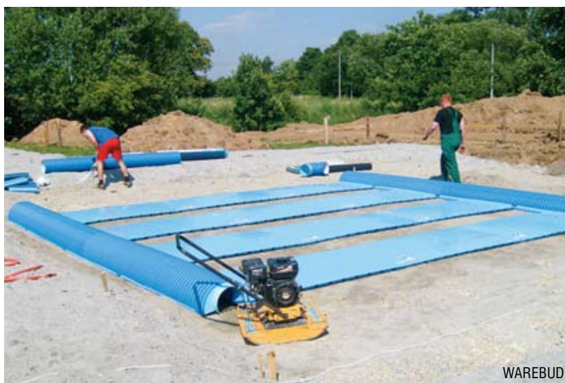
Fot. 7. Równne podłoże z zagęszczoną podsypką żwirową to podstawa sukcesu przy płytowym GWC.
