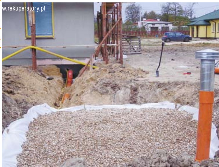
Fot. 5. Żwirowy gruntowy wymiennik ciepła przygotowany do ułożenia warstw izolacyjnych i obsypania gruntem.
